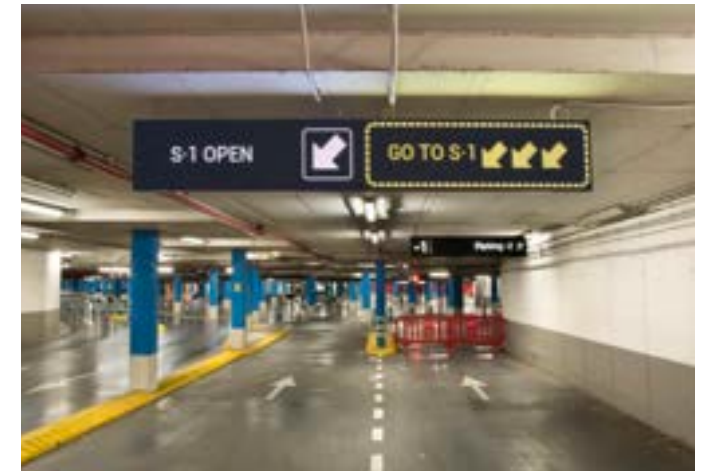
Figura 12.6: Sistema de señalización dinámica del estado de ocupación de un estacionamiento, ayudando a los usuarios.
