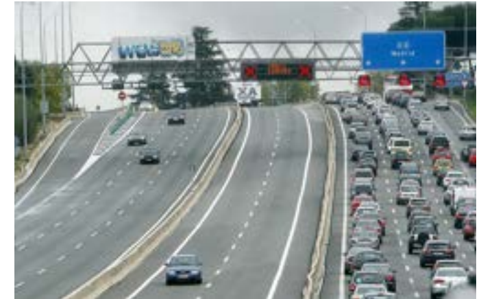
Figura 7.17: Vía arterial BUS-VAO de Barcelona (C58).
