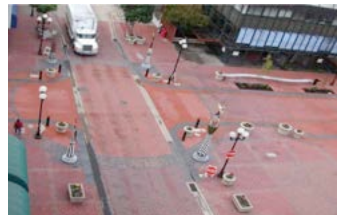
Figura 6.4: Cruce sin semaforización y vía diseñada para la movilidad de proximidad. Diseños que transmiten legibilidad
