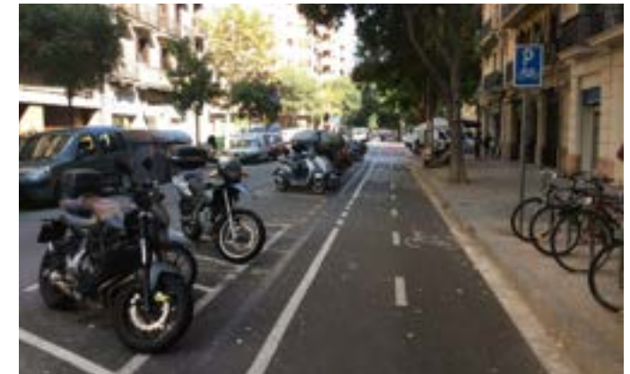
Figura 2.71: Mantenimiento insuficiente de red de bicicletas inhabilita parte del carril bici.
