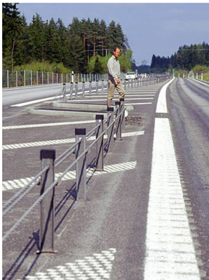
Figura 8.22: Aplicación de vallas flexibles en carreteras 2+1 para evitar el choque frontal, creado por Christopher Patten y promovido por Claes Gustav Tingvall.
